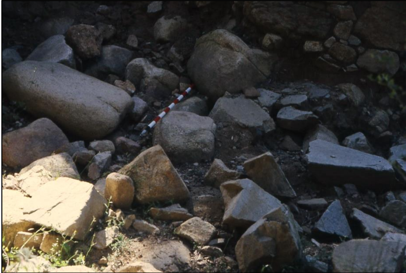
10 de maig de 1986. Destrucció del paviment de la porta meridional del poblat ibèric de Burriac. Foto: JC Alay.
