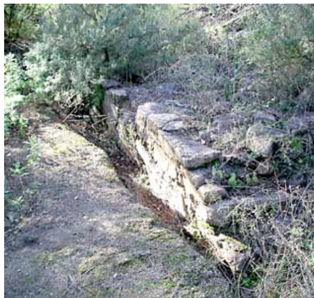
Parament (sòcol de fonamentació) torre dels Dos Pins
