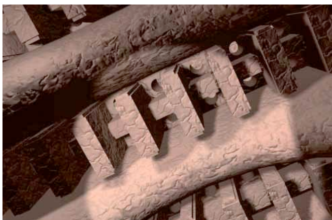
Estructura de la graella del forn de Ca l'Arnau
