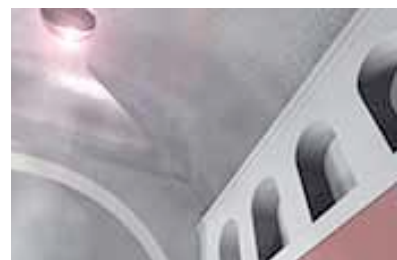
Coberta interior del caldarium amb volta de canó per a recollir les aigües provinents de la condensació
